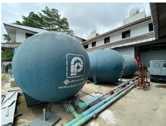
ภาพที่ 2.2-16 ถังเก็บน้ำสำรองของโครงการ
